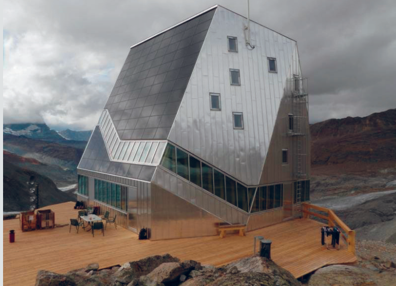
Individuelle Bauten: Die Monte-Rosa-Hütte bei Zermatt steht auf 2883 m ü. M. am nordwestlichen Fuss des Monte-Rosa-Massivs.
