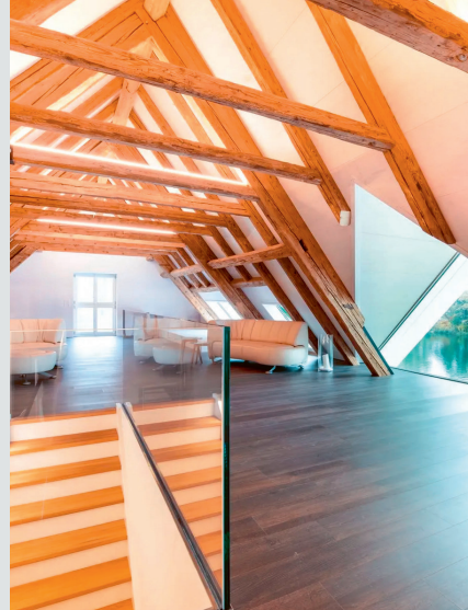
Beispiel einer Estrichsanierung der Jura Holzbau AG.
